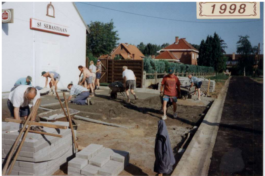
Vele handen maken licht werk bij het leggen van klinkers aan de zaal in 1998
